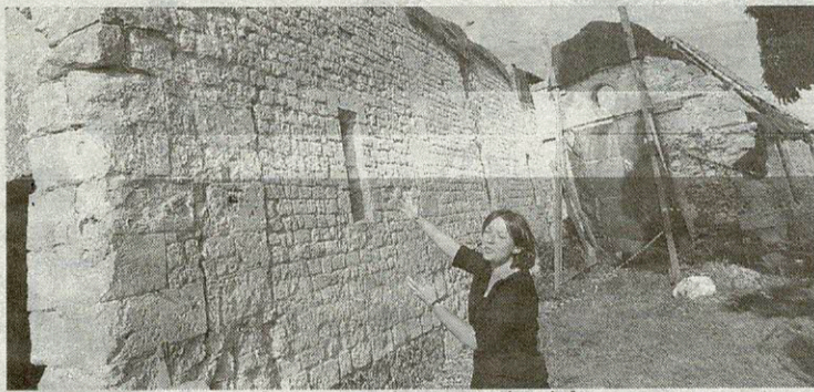
Le début des travaux de restauration est prévu à l'automne 2015
